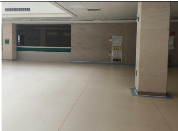
急诊科 DSA 机房上方输液大厅
