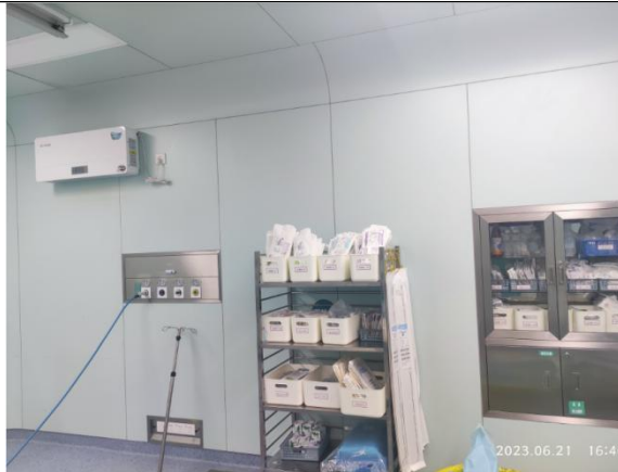
急诊科 DSA 机房北侧物品柜
