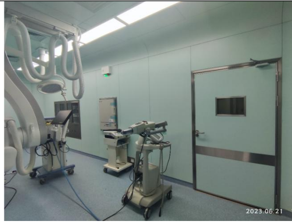
急诊科 DSA 机房西侧
